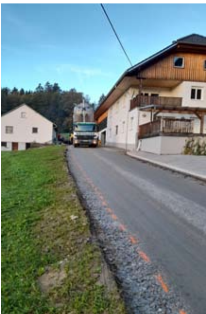
Sanierung Güterweg Asanger
