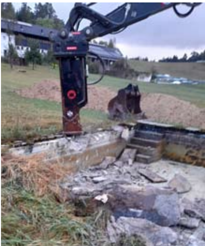
Abbruch alter Löschwasserbehälter
