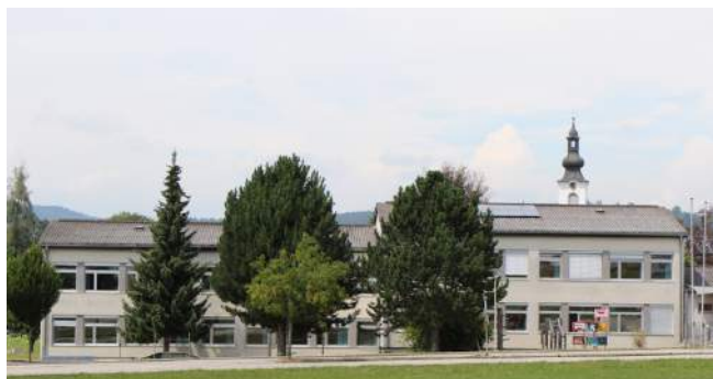
Die Generalsanierung der in die Jahre gekommenen Volksschule zählt zu den vordringlichsten Aufgaben.
