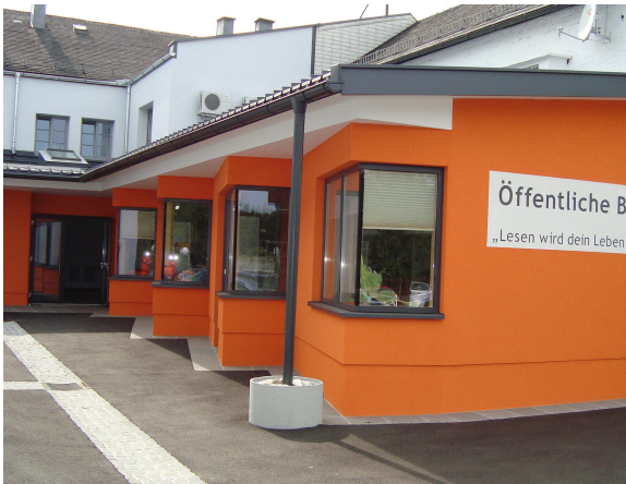
Die Öffentliche Bücherei ist vom Keller des Gemeindeamtes in das Markthaus übersiedelt. Eine helle, freundliche Bücherei samt öffentlichen WCs entstand im vorher trostlosen, desolaten Hinterhof.
