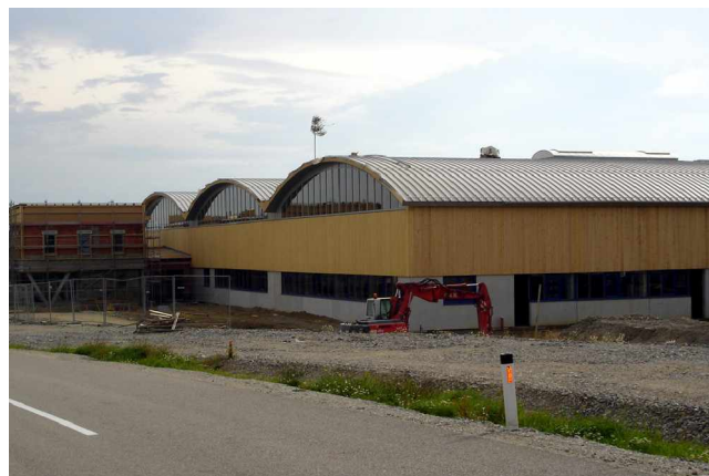
Die Bauarbeiten beim neuen Betriebsgebäude in Witzersdorf gehen zügig voran.
