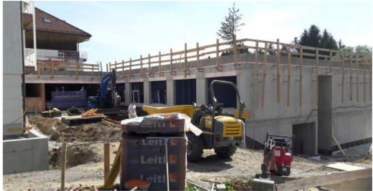
Der zweigeschoßige Zubau ist im Rohbau fertiggestellt: Im UG sind Funktionsräume, im EG können 15 Einbettzimmer genützt werden. Derzeit werden in Fenster sowie die Installationen montiert.
