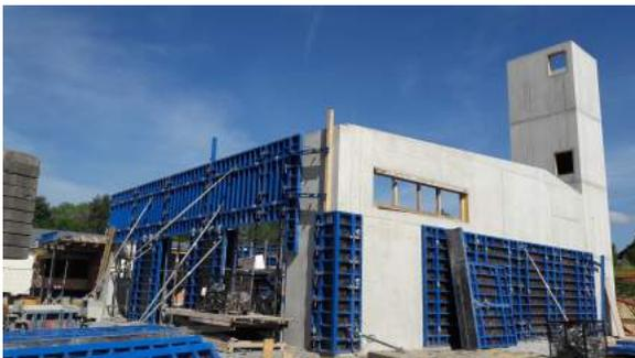
Die KFZ-Einstellhalle und der Schlauchturm werden in Betonbauweise errichtet, der Kommando-, und Schulungsraum sowie die Sanitäräume hingegen in Ziegelbauweise.
