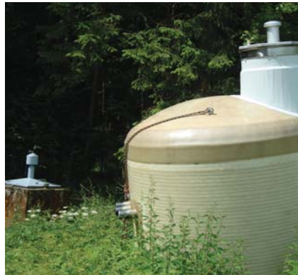
ganz links alter Quellsammelschacht, rechts davon der neue, noch oberirdisch gelagerte, welcher 2 alte Sammelschächte ersetzen wird. Die Quellableitungen bei Ollerndorf müssen durch den Wald teilweise neu verlegt werden.
