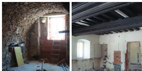
Die ehemaligen Postamtsräume mit der schweren Holztramdecke und das Uhrmachergeschäft Kaser mit einem uralten Steingewölbe werden bis zum Herbst generalsaniert und anschließend vermietet.
