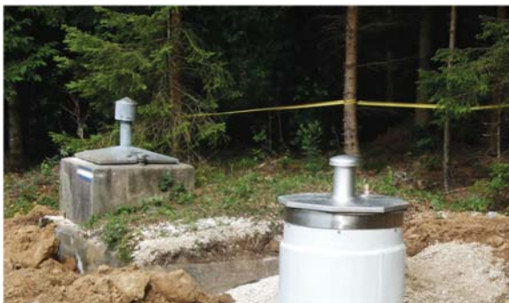
Im Bild der alte und der neue, bereits eingesetzte Sammel-schacht in Spielleiten © Richtsfeld R.
