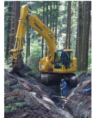
ganz links alter Quellsammelschacht, rechts davon der neue, noch oberirdisch gelagerte, welcher 2 alte Sammelschächte ersetzen wird. Die Quellableitungen bei Ollerndorf müssen durch den Wald teilweise neu verlegt werden.
