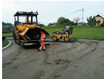
Im Kurvenbereich konnte die Straße um 2,5 m verbreitert werden, insgesamt ist nunmehr eine Mindestbreite von 5 m vorhanden.
