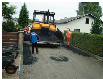
Sanierung eines Teilstückes der Molkereistraße
