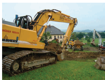
Kanalbau beim Haus Ruezhofer
