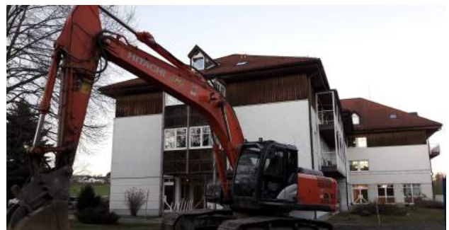
Altenheim-Umbau: Der Bagger greift noch im Dezember an
