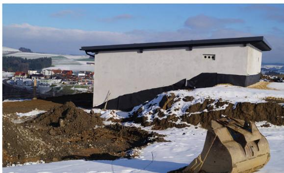
Der Wasserhochbehälter in Römersdorf wurde kurz vor Wintereinbruch im Rohbau fertig gestellt, der Vollwärmeschutz konnte noch aufgebracht werden. Dieser ist zur Vermeidung von Kondenswasser an den Innenwänden notwendig. Als Dichtheitsprobe wurden die beiden Wasserkammern gefüllt, wozu 500 m<sup>3</sup> Trinkwasser vom alten Hochbehälter in der Moritz-Scheiblstroße nach Römersdorf hinaufgepumpt werden mussten. Erst dann konnten die Wasserkammern mit Erde überschüttet werden.
