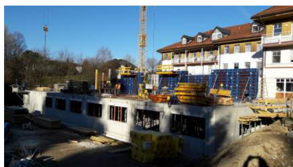
Der südliche Zubau an der Rückseite des Bezirksaltenheimes wächst aus dem Boden. Dieser nur 2-geschoßige Trakt wird die Aussicht aus den bestehenden Zimmern nicht beeinträchtigen. Im Untergeschoß sind Personal- und Funktionsräume untergebracht.
