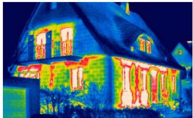
Mit einer Thermografie können die Schwachstellen eines Gebäudes festgestellt werden
