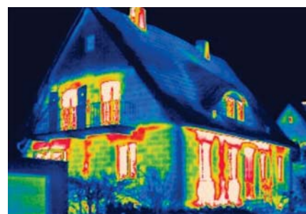
Mit einer Wärmebildkamera erkennt man die Schwachstellen des Hauses
