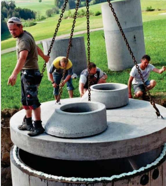
Bauarbeiten an der neuen Kläranlage in Atzesberg
