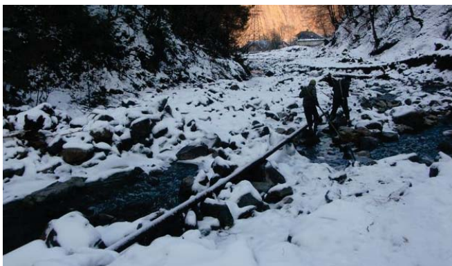
Die nach dem Hochwasser provisorisch errichtete Wasserleitung
