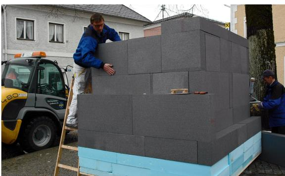
Um den Holzkasten wird 30 cm Dämmung angebracht
