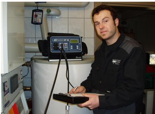
Meßtechnische Überprüfung der Funktionsfähigkeit der Feuerungsanlage
